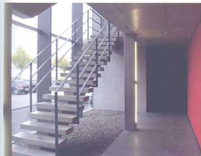
2. Die Nutzung der Decken als große Heizflächen: Die Betonkernaktivierung der Sichtbetondecke verteilt die Wärme, die aus einer Geothermieanlage stammt, gleichmäßig und behaglich im Raum.
