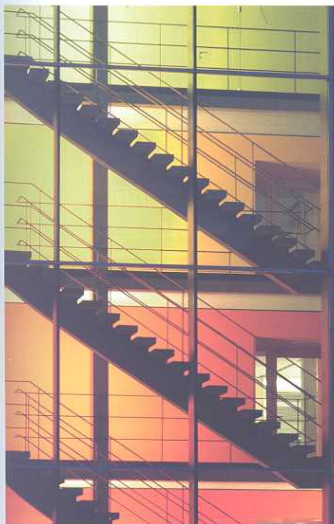
Das Energiekonzept von BOB setzt sich aus drei Hauptkomponenten zusammen: 1. Eine extrem wärmedämmte Außenhülle, die zum Großteil aus einer Lochfassade mit vorgehängten Ziegelplatten besteht. Aber auch die Glasfassade im Treppenhaus schnallt den Energiegürtel eng.
